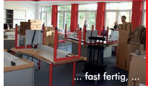
... mitten im Umbau, ...
